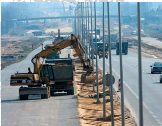
Budowa drogi S7, fot. GDDKiA.
