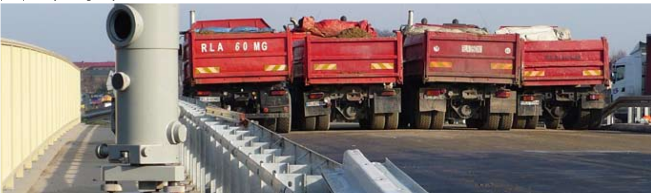
obciążenia próbne obiektu mostowego
