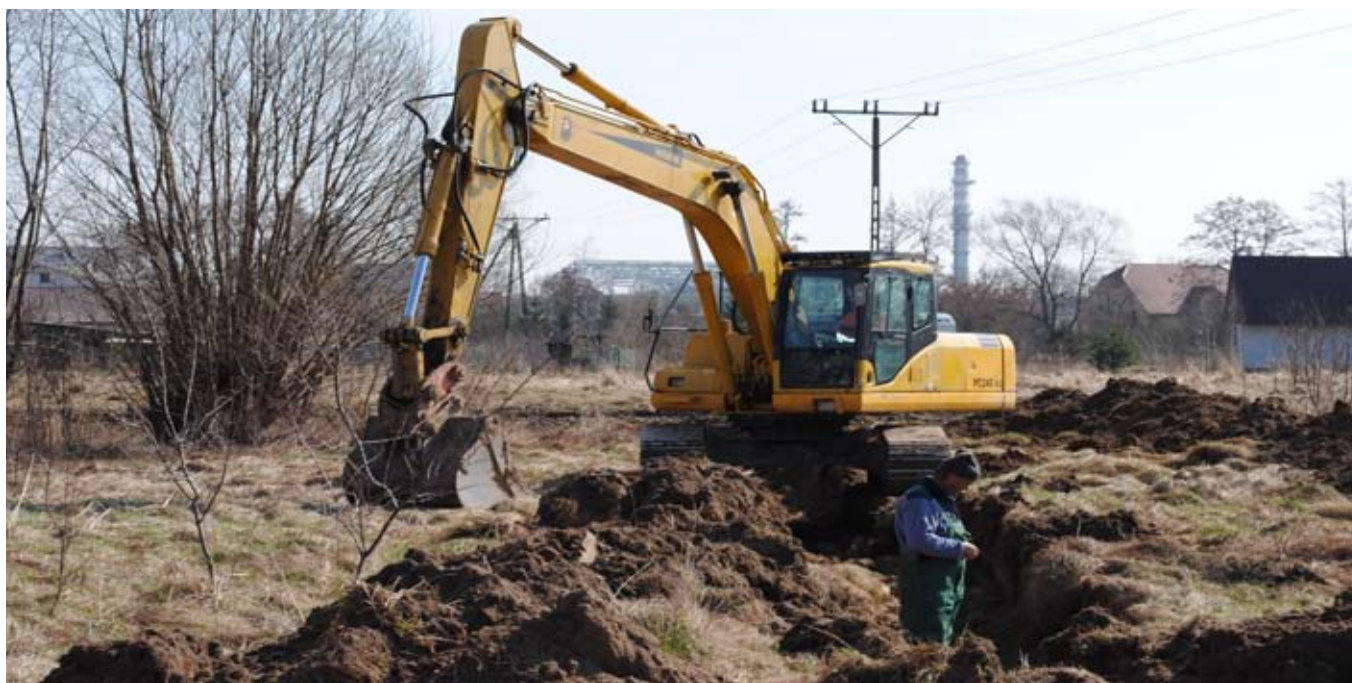
w budowie jest już ponad 9000 km sieci kanalizacji sanitarnej
