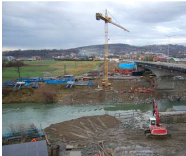
odcinek Łabuzie w budowie
