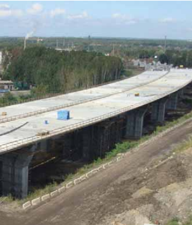
Konstrukcja ustroju nośnego nasuwana z wytwórni przy podporze nr 29
