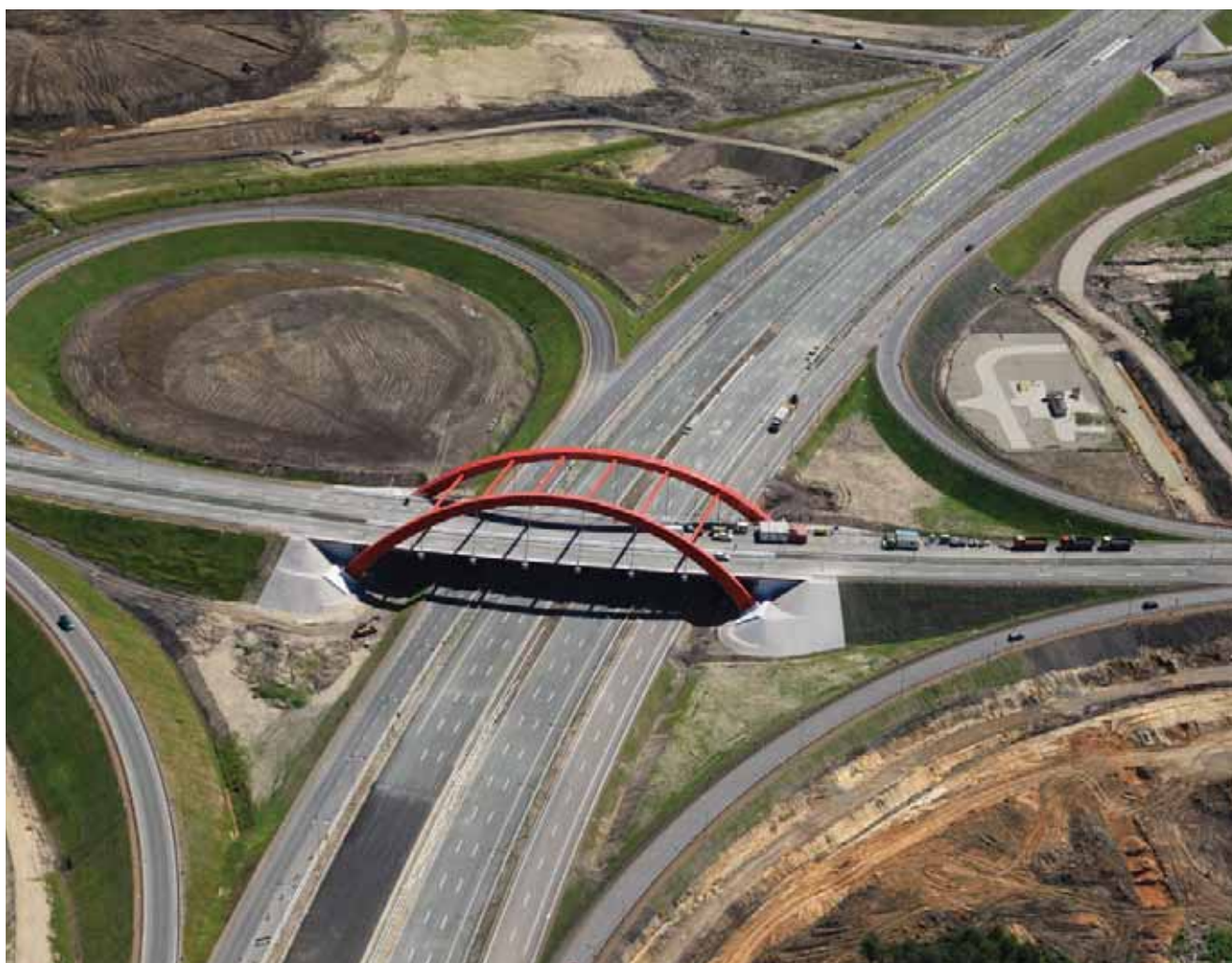
Największy w Polsce węzeł autostradowy – Gliwice-Sośnica
