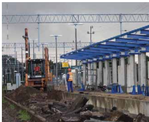
Modernizacja układu torowego na stacji Ciechanów
