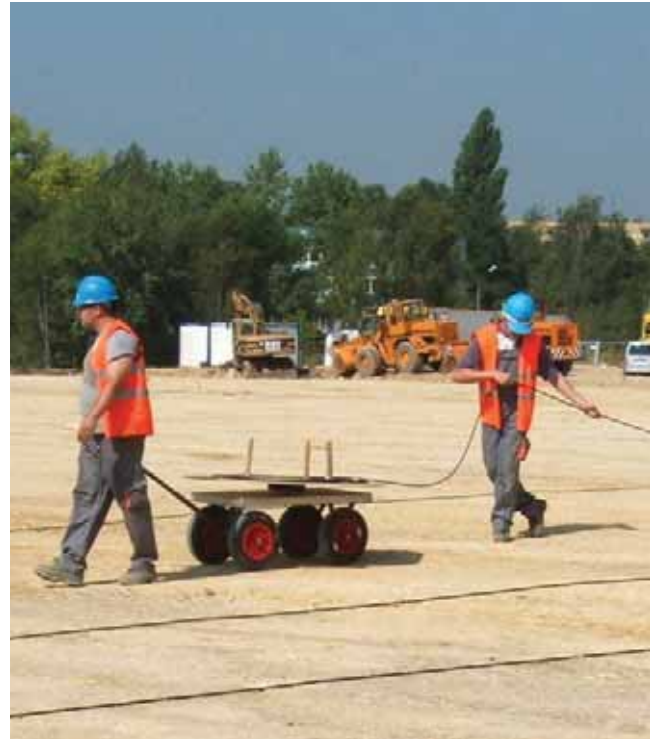
Układanie ciągów monitoringu przemieszczeń pionowych na odcinku Pyrzowice-Piekary Śląskie
